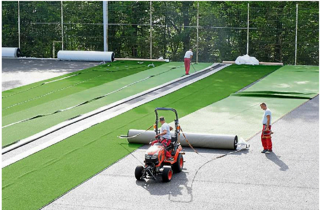
Bahn für Bahn wird das künstliche Grün in Daisbach verlegt.
