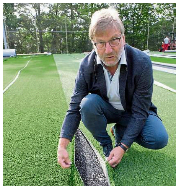
Planer Kurt Seegmüller zeigt die Kanten, die verklebt werden.
